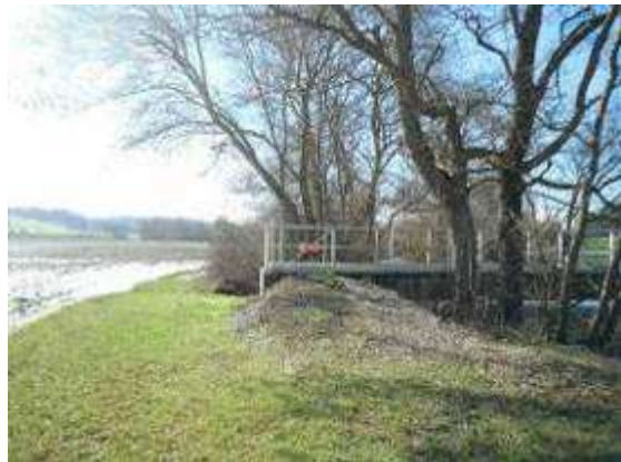
Figure 14 : Passerelle d'accès à la prise d'eau
