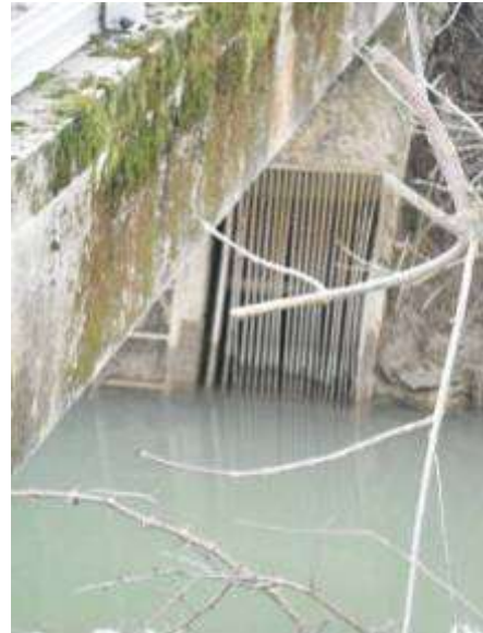
Figure 12 : Dégrilleur
